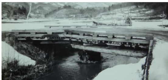
水木造の坊沢二の橋
